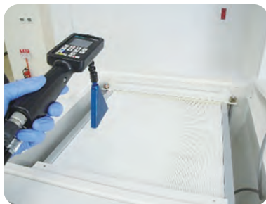
HEPAフィルタ性能試験(透過率試験)
